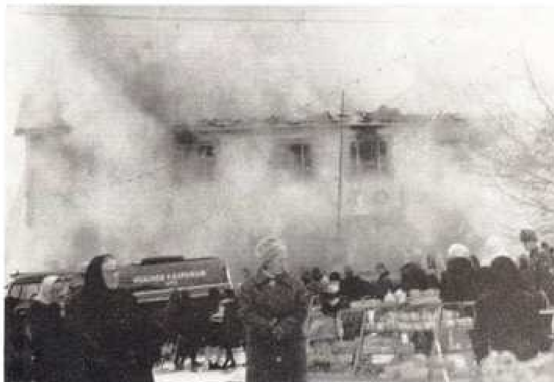
6. 1. 1962 raivonnut tulipalo tuhosi lyhyessä ajassa Asematie varressa sijainneen kookkaan liiketalon.
